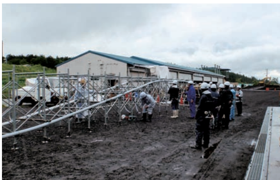
半透明シースにより高粘性型および超低粘性型PCグラウトの充填状況を目視確認している様子。
