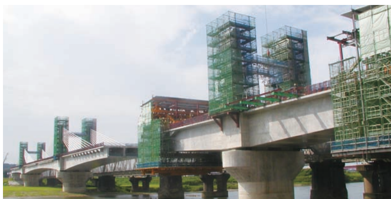
張出し施工状況
