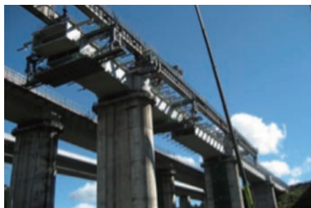
セグメントの架設
