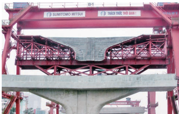
足場・型枠・支保工のシステム化
