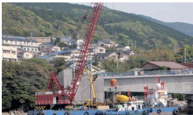
クレーン船を使った作業
