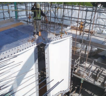
波形鋼板架設
