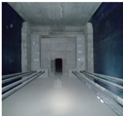
箱桁内の中央ヒンジ部
