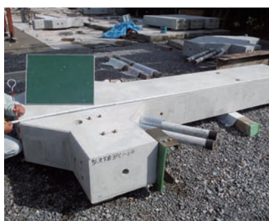
プレキャスト部材の製作
