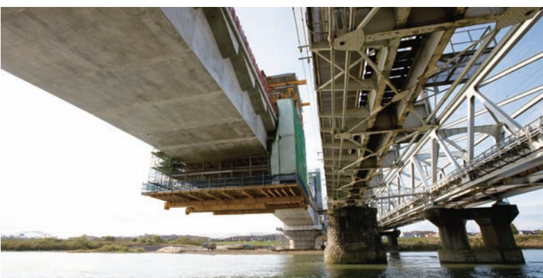
鉄道近接作業状況
