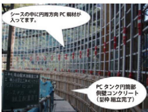
写真-1 巴周方向PC鋼材配置
