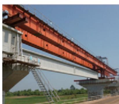
写真-1 アプローチ橋PCI桁架設
