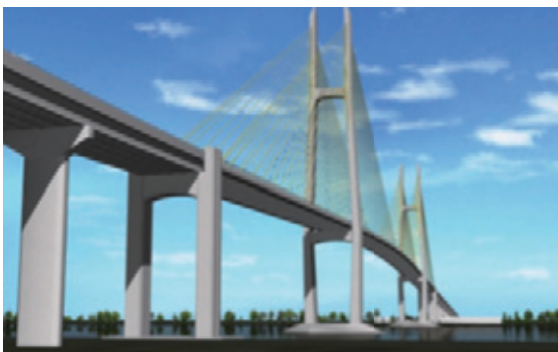
図-1 メイン橋バース(3径間連続PC斜張橋) 提供:JICA(独立行政法人国際協力機構)
