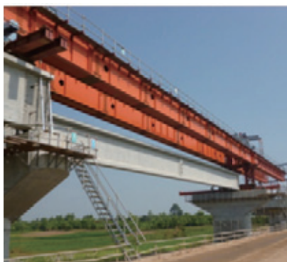
写真-1 アプローチ橋PCI桁架設
