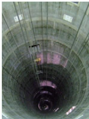
写真-2 コンクリート打設中の心柱内
