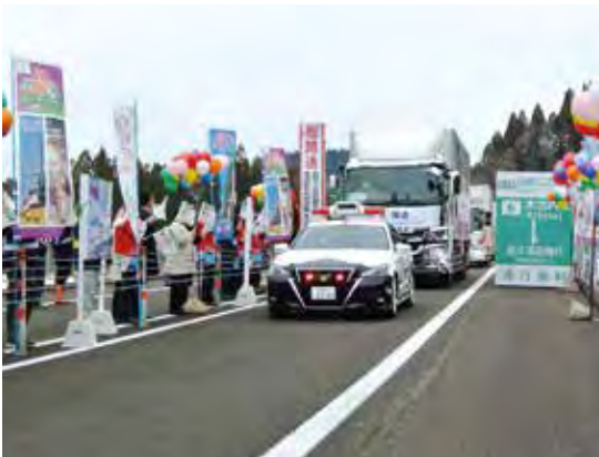
▲ 函館・江差自動車道茂辺地木古内道路 パトカーの先導による通り初め
