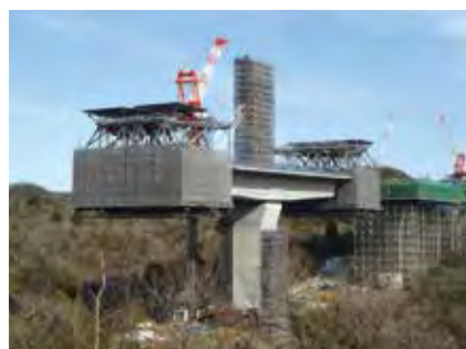
▲ 最初の現場(施工中)
