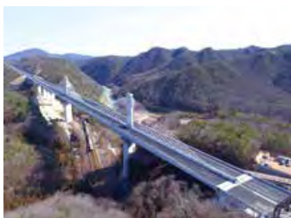
▲ 最初の現場(施工完了)
