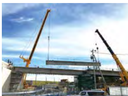
▲現在の現場(架設状況)
