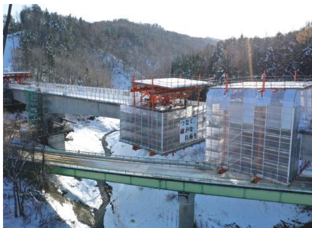
▲ 現国道への飛来物落下防止対策
