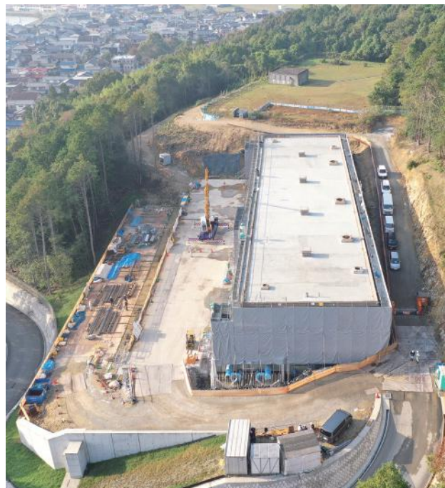
▲ 分割施工1槽目完成
