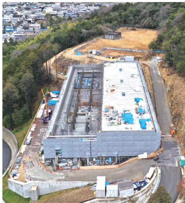
▲ 分割施工2槽目
