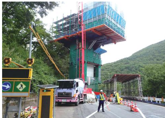
▲ P2橋脚近接の安全対策(現道上に防護設備を設置)
