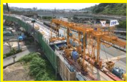
観音寺高架橋・風祭ランプ橋 床版取替工事 (p.30)
