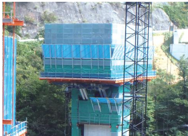
▲ P2橋脚の安全対策(青い養生枠と緑のメッシュシート)
