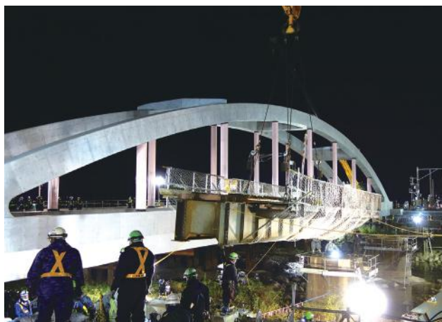
▲ 橋梁切替状況:旧橋梁撤去中
