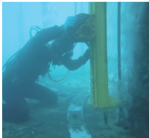
▲ 潜水士による軸方向鉄筋削孔作業
