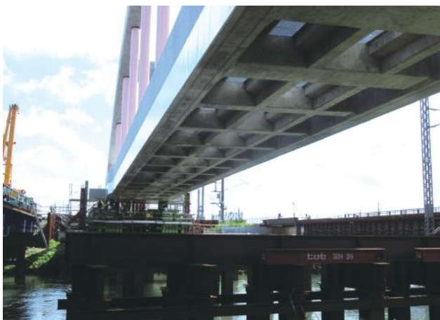
▲ 桁降下前・開床桁状況
