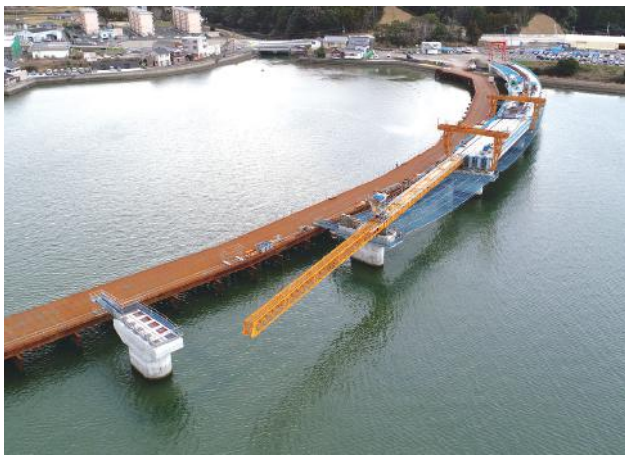
▲ 架設桁架設
