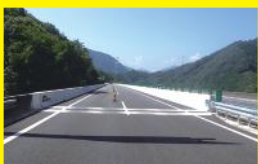
烏帽子第一橋・烏帽子第二橋 床版取替工事 (p.36)
