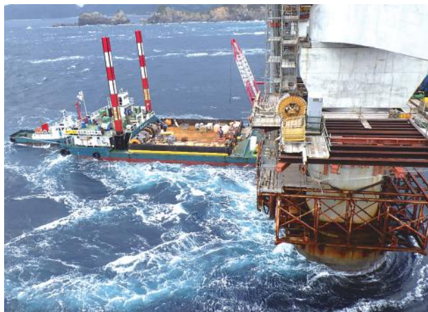
▲FC船での資機材の運搬状況
