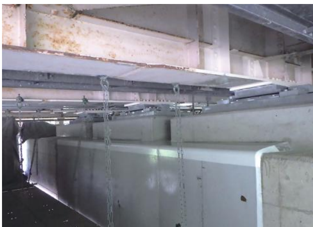
▲ 支承取替完了
