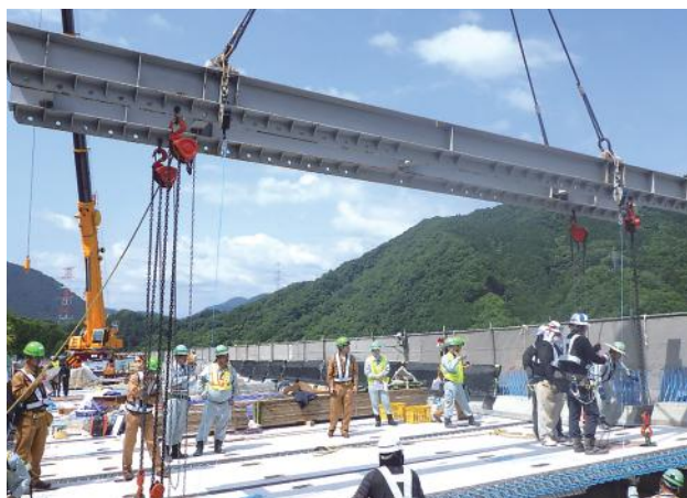
▲ 新設床版架設
