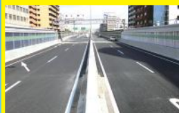
阪神高速守口線 床版取替工事 (p.34)
