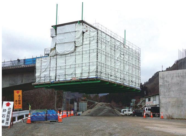
▲ 施工状況 (低床型の架設機械)
