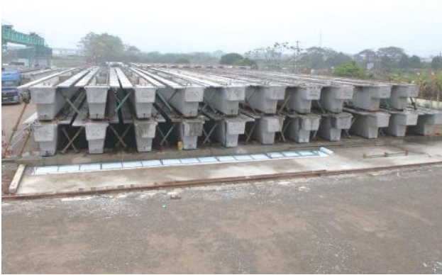
▲ヤードにてT桁製作
