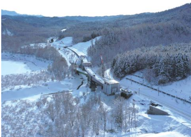
▲ 厳冬期の施工状況(写真の左側は桂沢湖)
