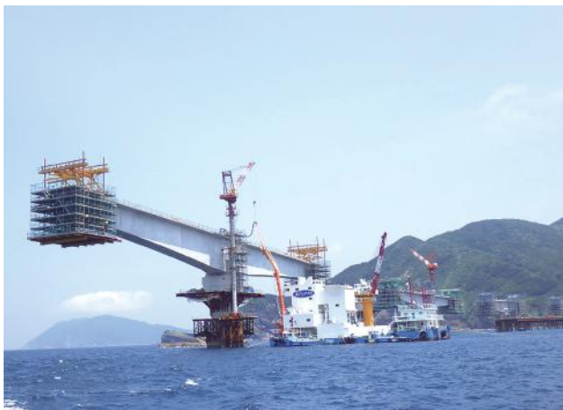
▲ミキサー船でのコンクリート打設状況
