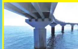
石部海上橋 耐震補強工事 (p.32)
