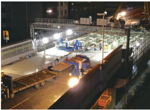
▲ 工事中(夜間床版架設)
