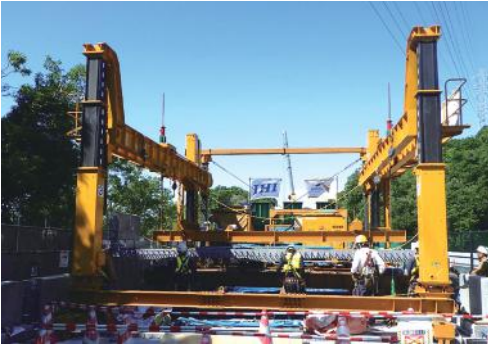
▲ 床版架設機による架設(観音寺高架橋)
