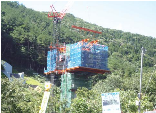
▲ 移動作業車組立状況
