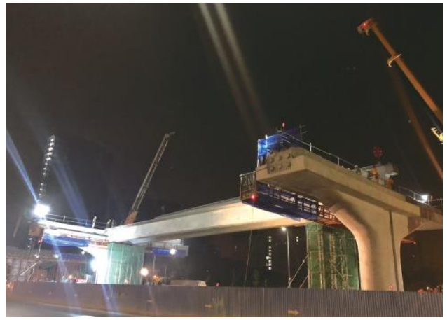
▲トラッククレーン架設
