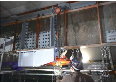
▲ 外ケーブルによる補強(観音寺高架橋)
