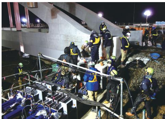
▲ 橋梁切替状況:橋梁位置の最終調整
