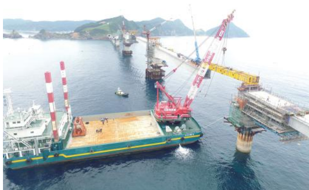
▲FC船での架設桁の設置状況
