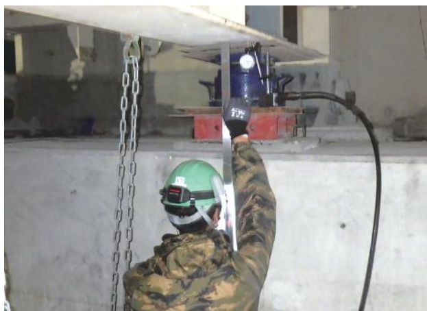
▲ ジャッキ扛下量測定
