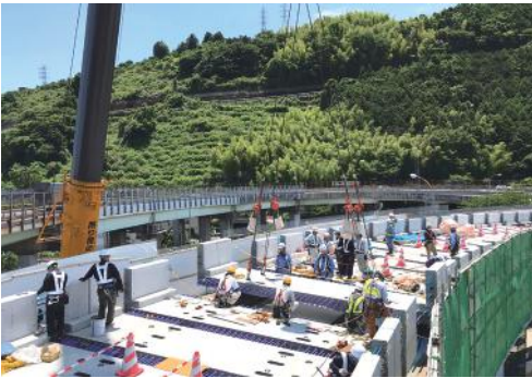
▲ 大型クレーンによる架設(風祭ランプ橋)
