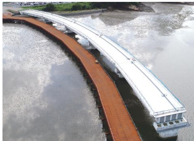
▲ 当社施工分3径間完了(他工事2径間含む)
