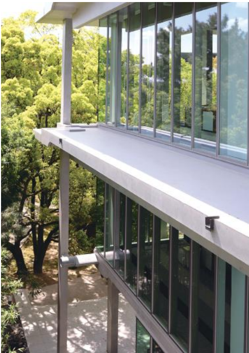
▲写真-3:北東から見る
