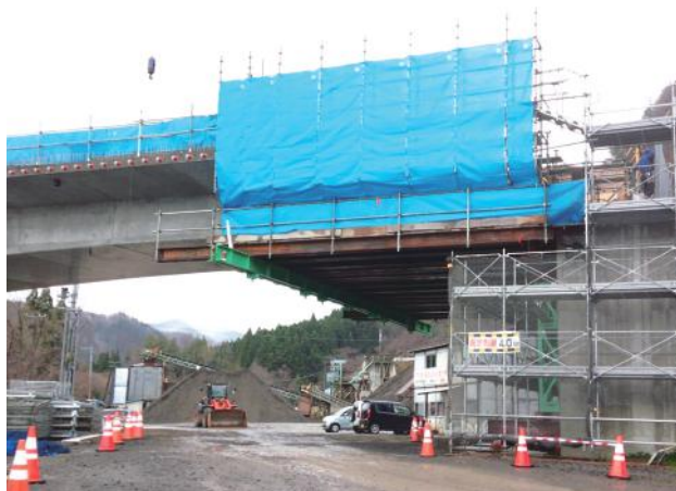
▲ 施工状況 (側径間部)
