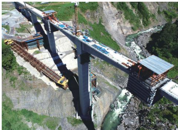
▲ 片持架設状況(大型インクライン・超大型移動作業車の導入)
