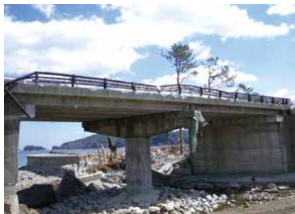
▲ 国道45号 波板橋(単純プレテンションT桁橋 若手県大槌町) 高欄は被災したが、橋梁本体は無事だった
