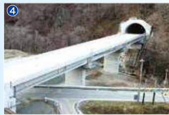
▲ 宮古盛岡横断道路 新栃刈橋
