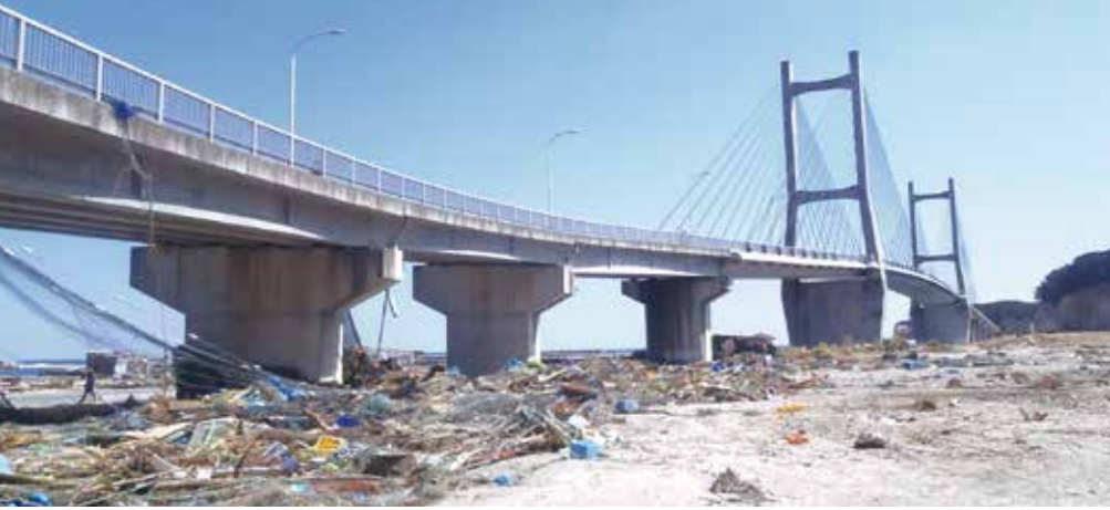
▲ 震災直後の松川浦大橋(福島県)
