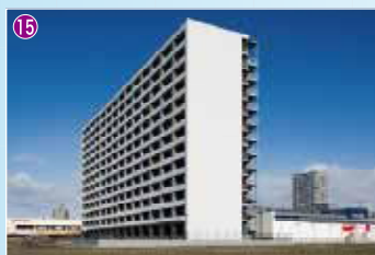
▲ あすと長野復興公営住宅
