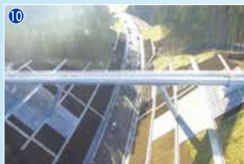
▲ 三陸縦貫自動車道 8号跨道橋
