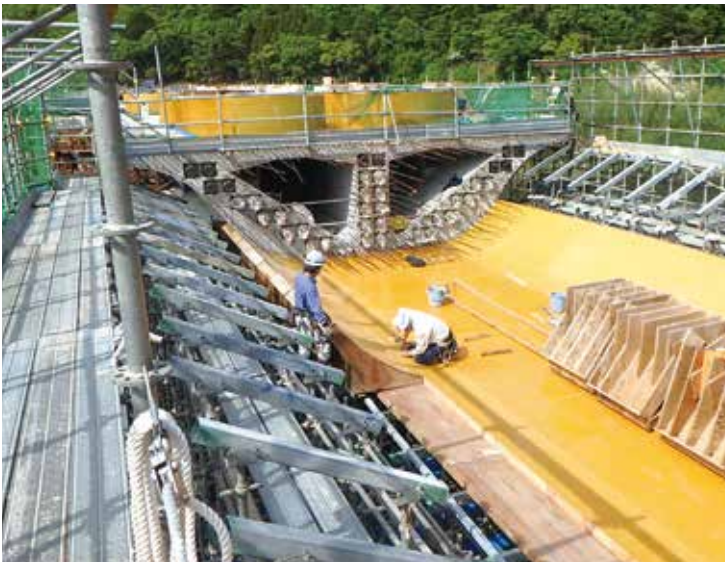
▲ 型枠 (櫛枠) 組立状況
