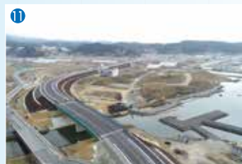
▲ 国道45号 水尻橋
