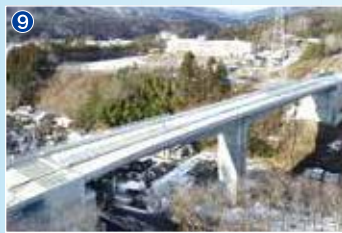
▲ 三陸縦貫自動車道 東八幡前橋
