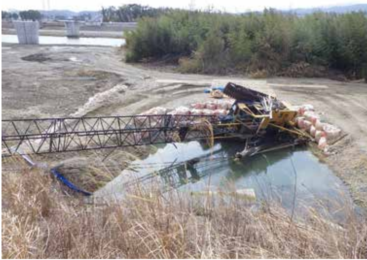
▲ 施工前 (A2橋台側に横たわるクローラクレーン)
