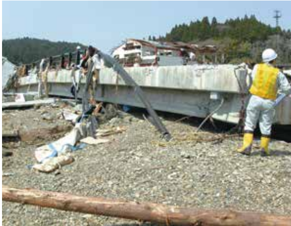
▲ PC建協による調査状況(宮城県 歌津大橋)
