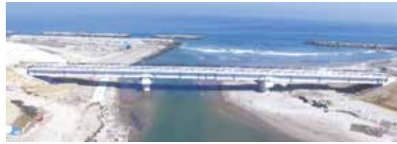
▲写真-2 塚原工区：災害復旧工事として原型復旧したハツカラ橋(PC3径間連結ポストテンション方式パルプT桁橋)
