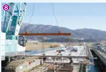
▲ 気仙大橋(国道45号)
