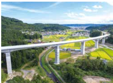
▲ 写真-3 高耐久仕様で試した鳥谷高架橋
