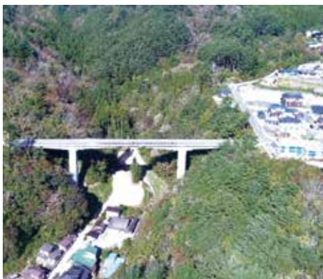
▲ 高台へ移転した宅地へ繋がる里大橋
