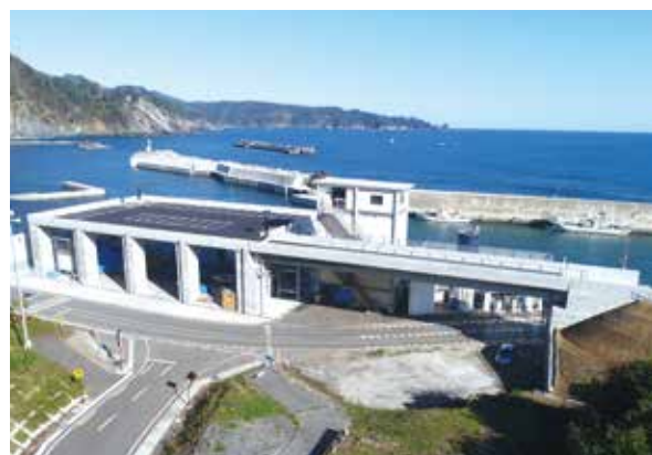
▲ 島の越漁港人工地盤
