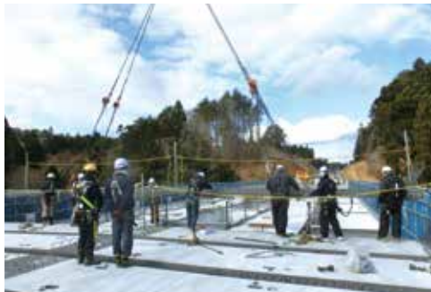
▲ 写真-1 プレキャストPC床版を採用した小山川橋
