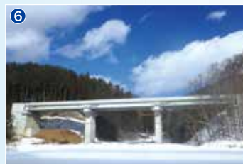
▲ 東北横断自動車道釜石秋田線 長洞橋
