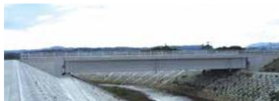
▲写真-1 天神工区：二級河川山田川に架かる前原橋(PC単純ポストテンション方式コンボ橋)
