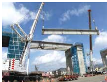
▲ 北陸新幹線：桁架設の様子
