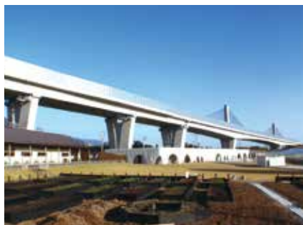
▲ 新名神高速道路 菟野第二高架橋
