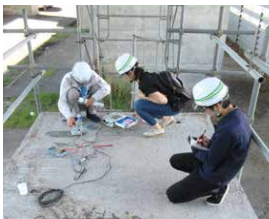
▲コンクリート中の鉄筋の腐食診断
