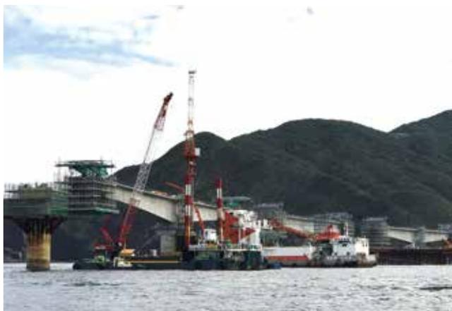
▲ コンクリートミキサー船での打設状況
