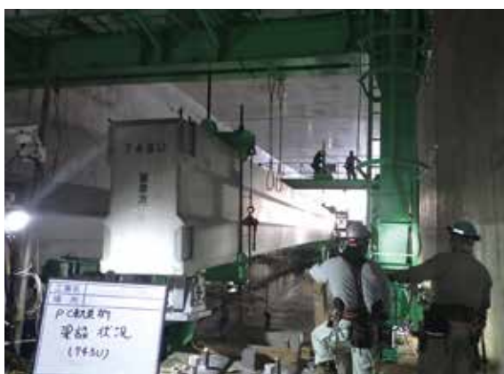
▲写真-1 地下区間でのPC軌道桁の架設
