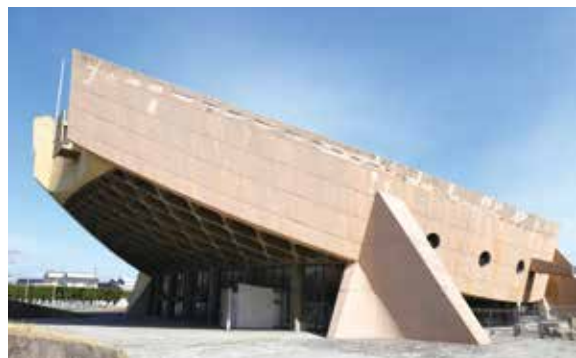
▲ 旧香川県立体育館 1964年、元塩田の埋め立て地に建てられた体育館は、1300人収容のアリーナとして様々なスポーツに利用されてきた。吊り構造の独創的な形状とそのスケールに圧倒される。
