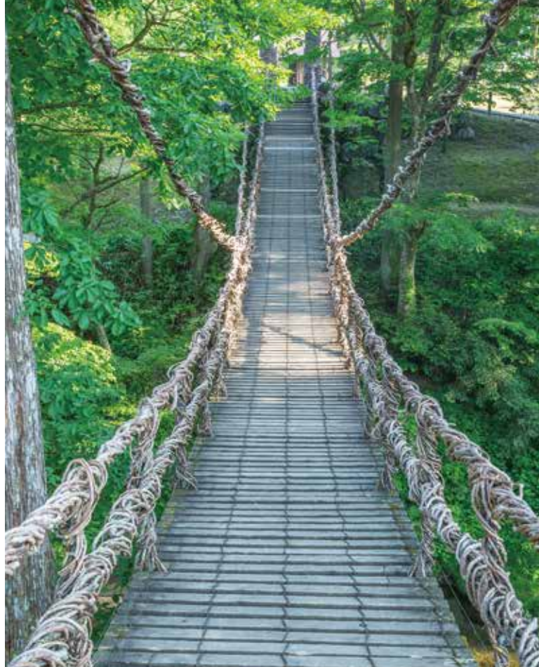
▲ 祖谷のかずら橋 日本三奇橋のひとつ、国の指定重要有形民俗文化財。平家伝説ゆかりの橋は長さ45m・幅2m・水面からの高さ14m。3年毎に架け替えが行われている。
