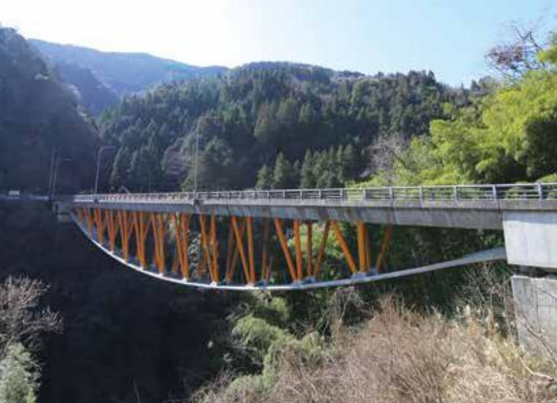
▲ 青雲橋 単径間PC複合トラス橋、橋長97.0m、2004年竣工。
