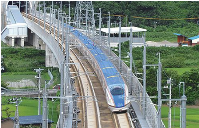
▲ 整備新幹線の整備方式で建設された北陸新幹線 (写真提供：鉄道・運輸機構)
