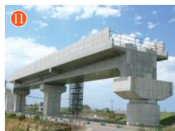
11 常願寺川霞提橋梁
