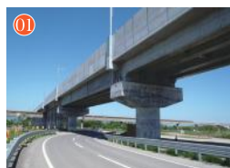
01 桜岱16号線架道橋
