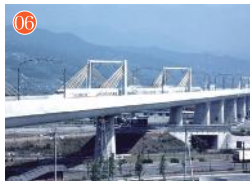
06 屋代南架道橋
