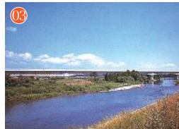
03 第2阿武隈川橋梁
