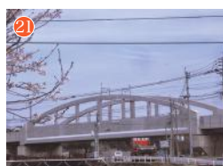
21 繁根木川橋梁
