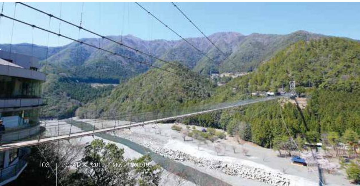
◀谷瀬の吊り橋 全長297.7m、高さ54m。鉄線の人用吊り橋では日本一の長さを誇る。奈良県十津川村を流れる十津川(熊野川の支流)に架かり、上野地と谷瀬を結ぶ生活用として使われてきた。
