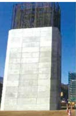
④橋梁下部工における埋設型枠の施工事例(橋脚)
