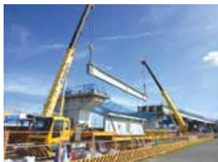
▲ 大型クレーンによる架設
