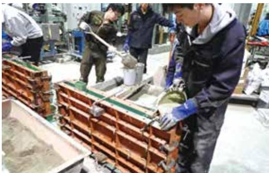
超高強度繊維補強コンクリート(UFC)の打込み
