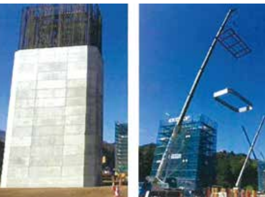
④橋梁下部工における埋設型枠の施工事例(橋脚)
