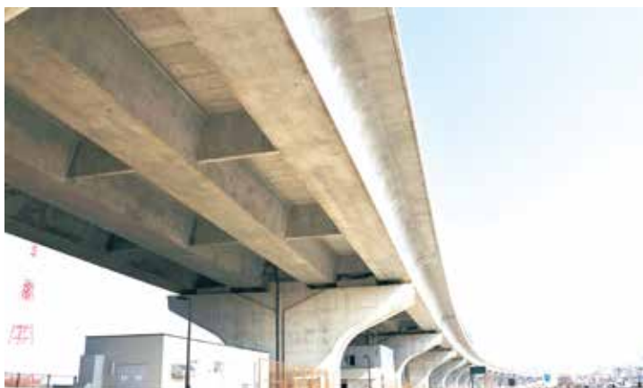
▶図3 Uコンポ橋の施工例
