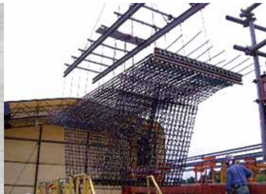
③橋梁上部工におけるプレハブ鉄筋の施工事例
