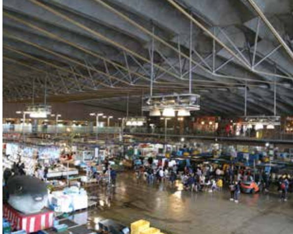
▲唐戸市場 ケーブルでPC版を吊る構造が採用され、柱のない大空間が形成されている。屋根を軽くするため、PC版にリブが設けられ、幾何学的なデザインとなっている。
