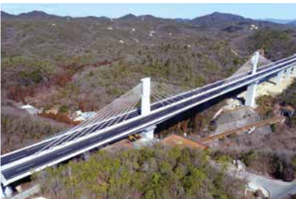
▲ 新名神高速道路 生野大橋
