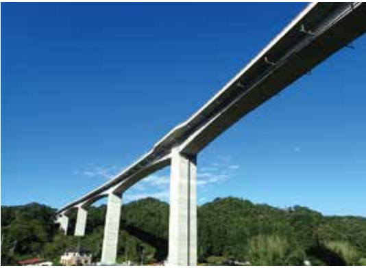
▲ 相馬福島道路 月舘高架橋
