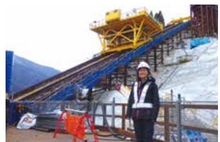
▲ 担当工事(インクライン)
