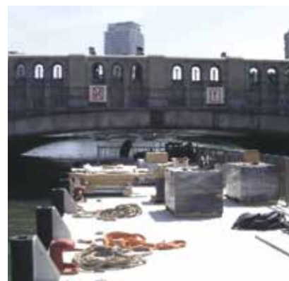
▲ 写真1 浮体の曳航状況
