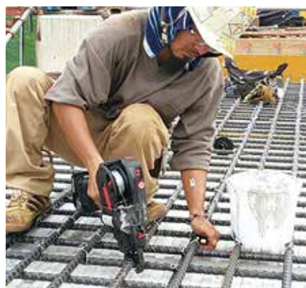
▲ 自動鉄筋結束装置を使用する現場作業員
