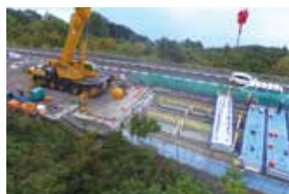
▲ プレキャストPC床版架設
