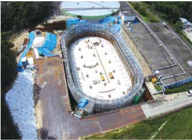
▲新設配水池 施工状況
