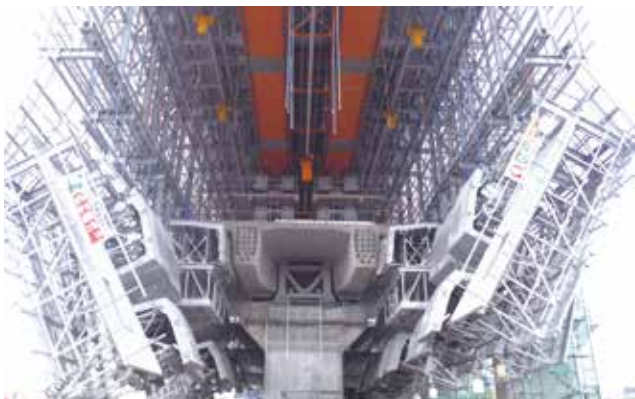
▲ 移動支保工型枠解放
