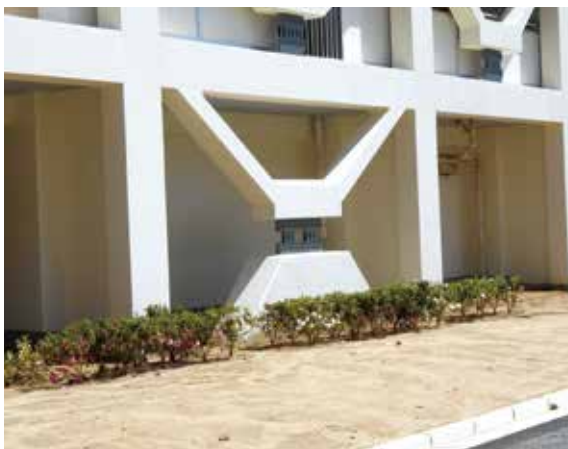
▲階高が高い1階部分のスマイルダンパフレーム
