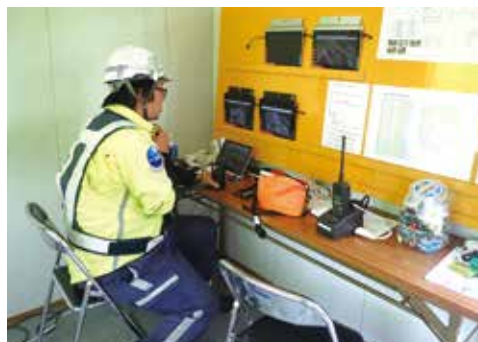
▲工事現場内に設けた監視室で規制帯内の状況を集中的に監視
