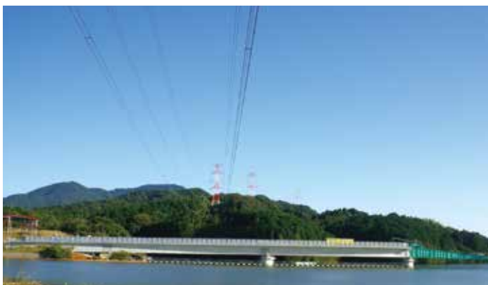
▲ 橋梁と高圧線の状況
