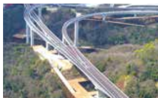
05. 雄ノ山高架橋
