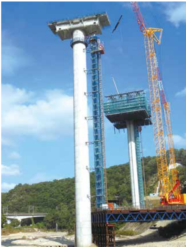
▲ 橋脚・柱頭部施工完了
