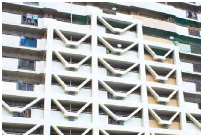
▲南側(バルコニー面)に取り付けたスマイルダンパフレーム
