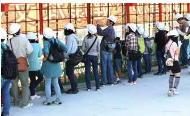
▲ 移動支保工を見学
