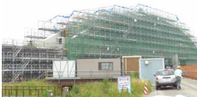
▲ 橋りょう施工時の足場支保工
