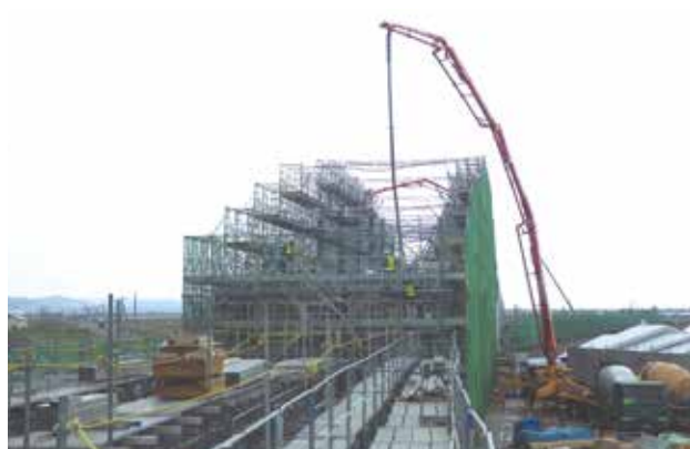
▲補剛桁コンクリート打設前状況
