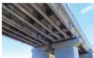
13. 沢底川橋補強
