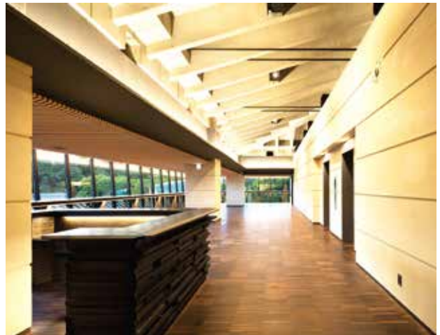
▲ 3階展示ロビー(PCaPC寄棟屋根の天井現し)【写真撮影：稲住写真工房】
