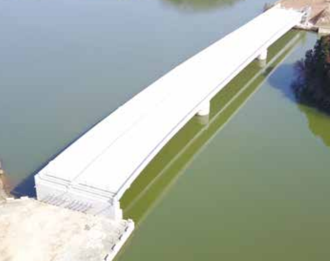
▲ 橋梁本体完成
