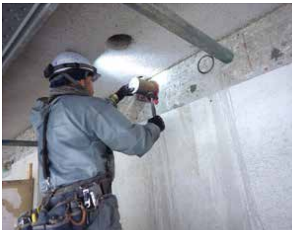
▲既存建物にせん断キーである鋼管コッターを取り付ける様子
