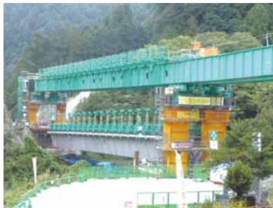
▲ 架設桁架設による架設風景
