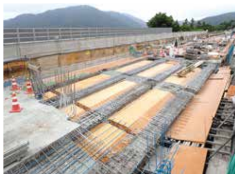
▲1次床版および1次床版に配置されている連結ケーブルをすべて撤去
