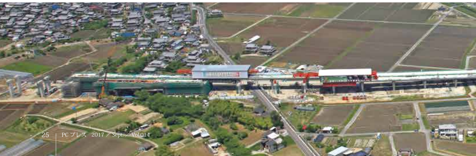
▼ 架設状況全景
