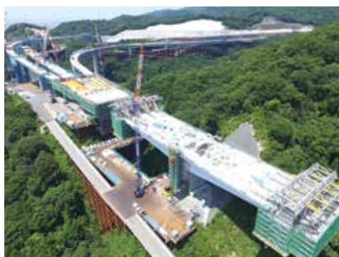
▲ 分合流部の張出し架設
