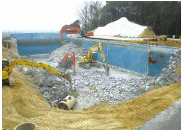
▲既設配水池 解体状況
