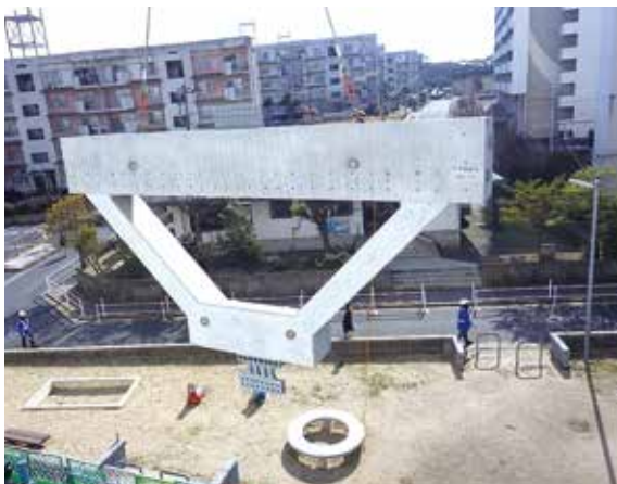
▲ブレース一体型PCa梁架設状況
