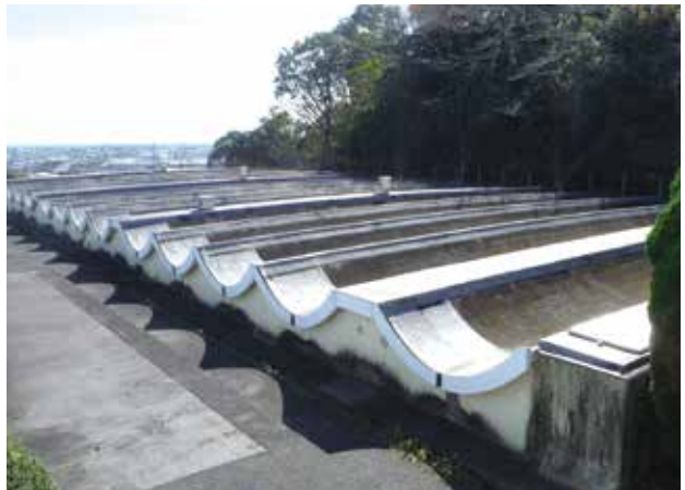
▲既設配水池 解体前
