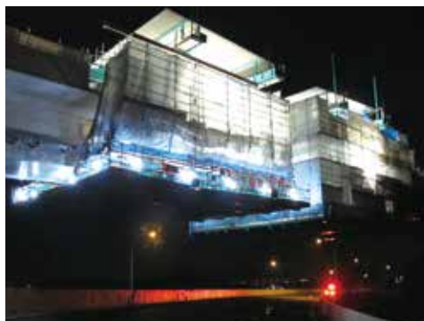
▲ 阪和自動車道上空の移動作業車
