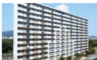
14. 北九州市八幡西区市営住宅耐震補強
