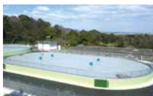
09. 山ノ手配水池1号池
