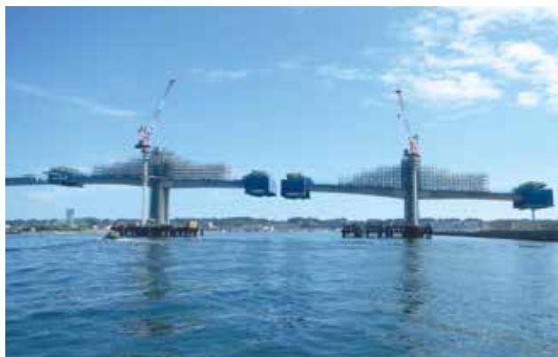
▲ 移動作業車を用いた張出し架設
