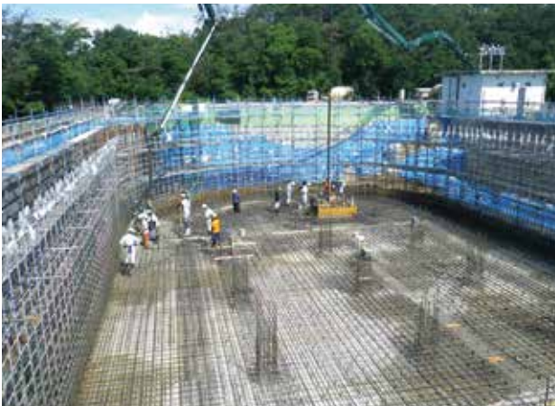
▲新設配水池 底板コンクリート打設状況
