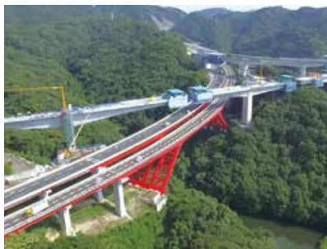
▲ 移行部の張出し架設
