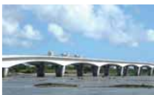
01. 臨港道路浦添線橋梁
