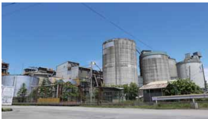
▲ 太平洋セメント上磯工場 現在稼働中のセメント工場としては国内最古、明治23(1890)年に創業を開始。国道から見えるセメントサイロはPC製 ▼ 海上栈橋 セメントを大型船に積み込む、2kmにおよぶ海上栈橋は印象的
