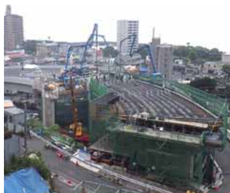
施工状況全景
