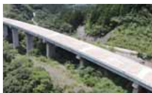
02. 北河内二号橋
