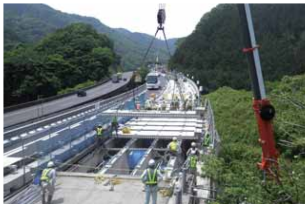
PC床版取替状況
