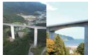
08. 越喜来高架橋・吉浜高架橋
