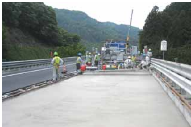
RC床版上面増厚状況
