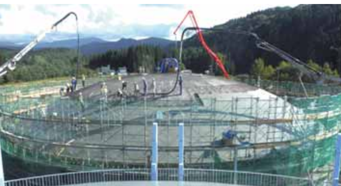
エアードーム打設状況
