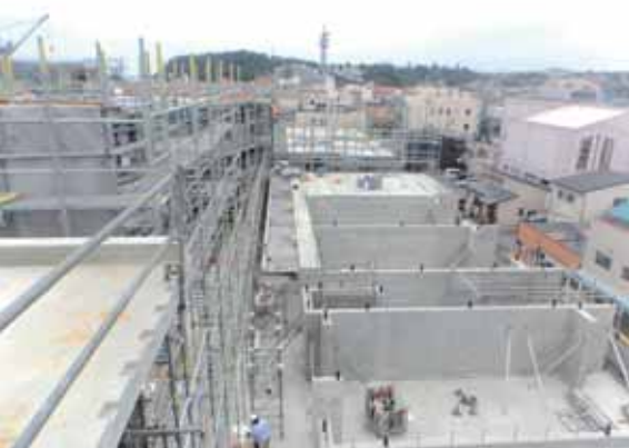
壁版と床版の架設
