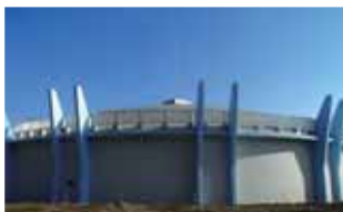
10. 野沢3号配水池
