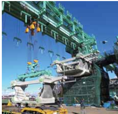
バタフライウェブを用いたU形セグメント吊上げ状況
