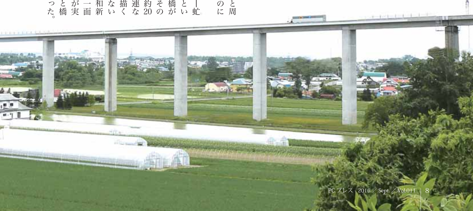
▼ 長流川橋（おさるがわばし） 橋長1772.5m、最大支間105.5mの連続ラーメン箱桁橋。片持架設工法、大型移動支保工、固定支保工により施工
