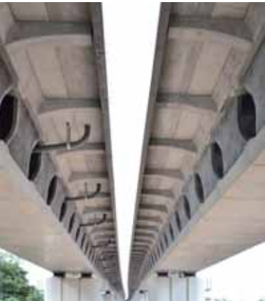
高架下より完成全景
