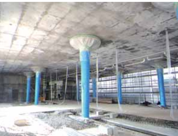
人工地盤を支持するPCaPC柱
