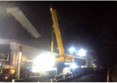
クレーン架設 (上部工)
