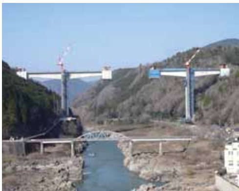
片持架設状況
