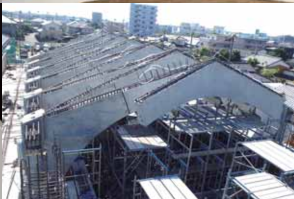
プレキャスト部材建方状況
