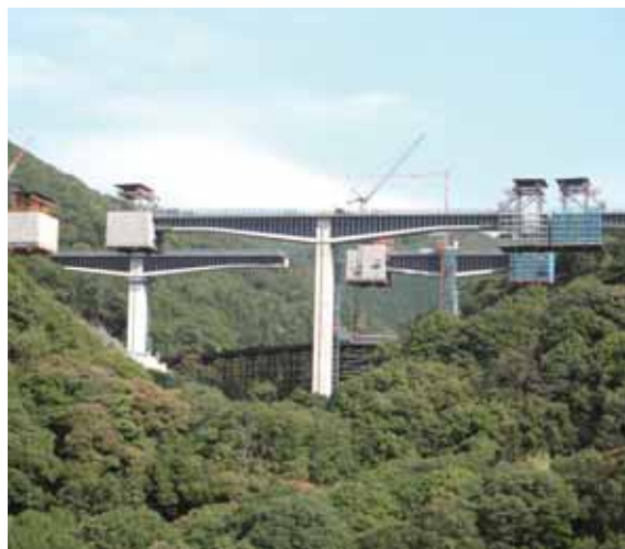
片持架設状況
