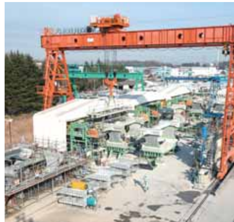
工場でのセグメント製作状況
