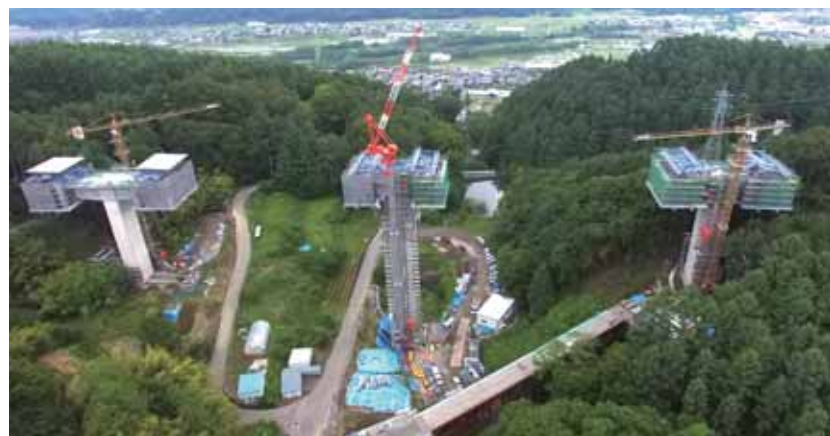
移動作業車6基同時施工
