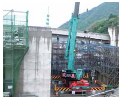
狭隘部の支保工
