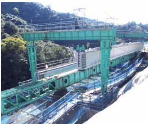
架設桁架設による架設風景
