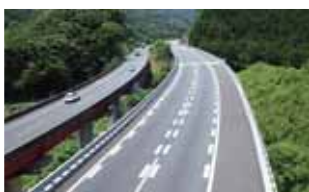
14. 上長房橋(上り線)床版補修
