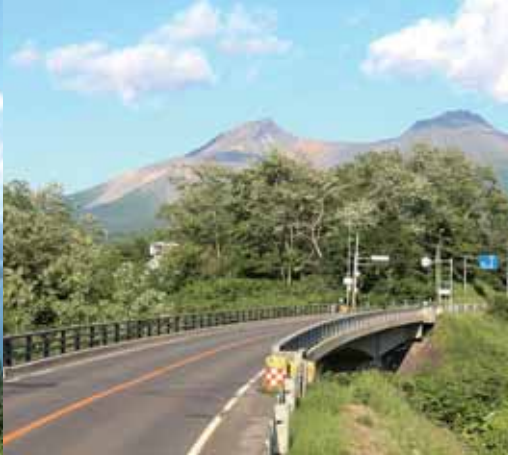
▲ 上姫川橋 橋長80m、世界初のPRC工法の3径間連続ラーメン箱桁橋。PCとRCの長所を活かした橋梁
