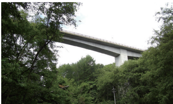
長野県川上村に架けられたPCの農道橋 埋沢大橋（うずみさわおおはし）
