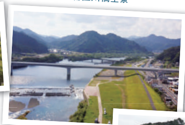
番匠川橋全景
