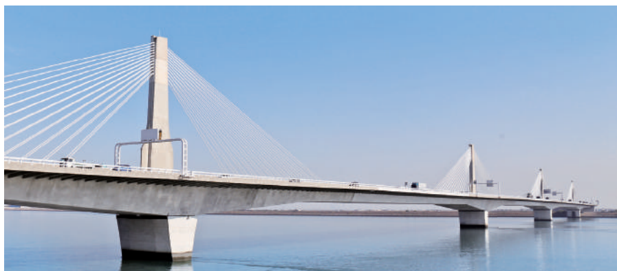
▲ 「トゥインクル」と呼ばれる木曽川橋・揖斐川橋は、世界初のPC・鋼複合連続エクストラードーズ橋(写真は木曽川橋)
