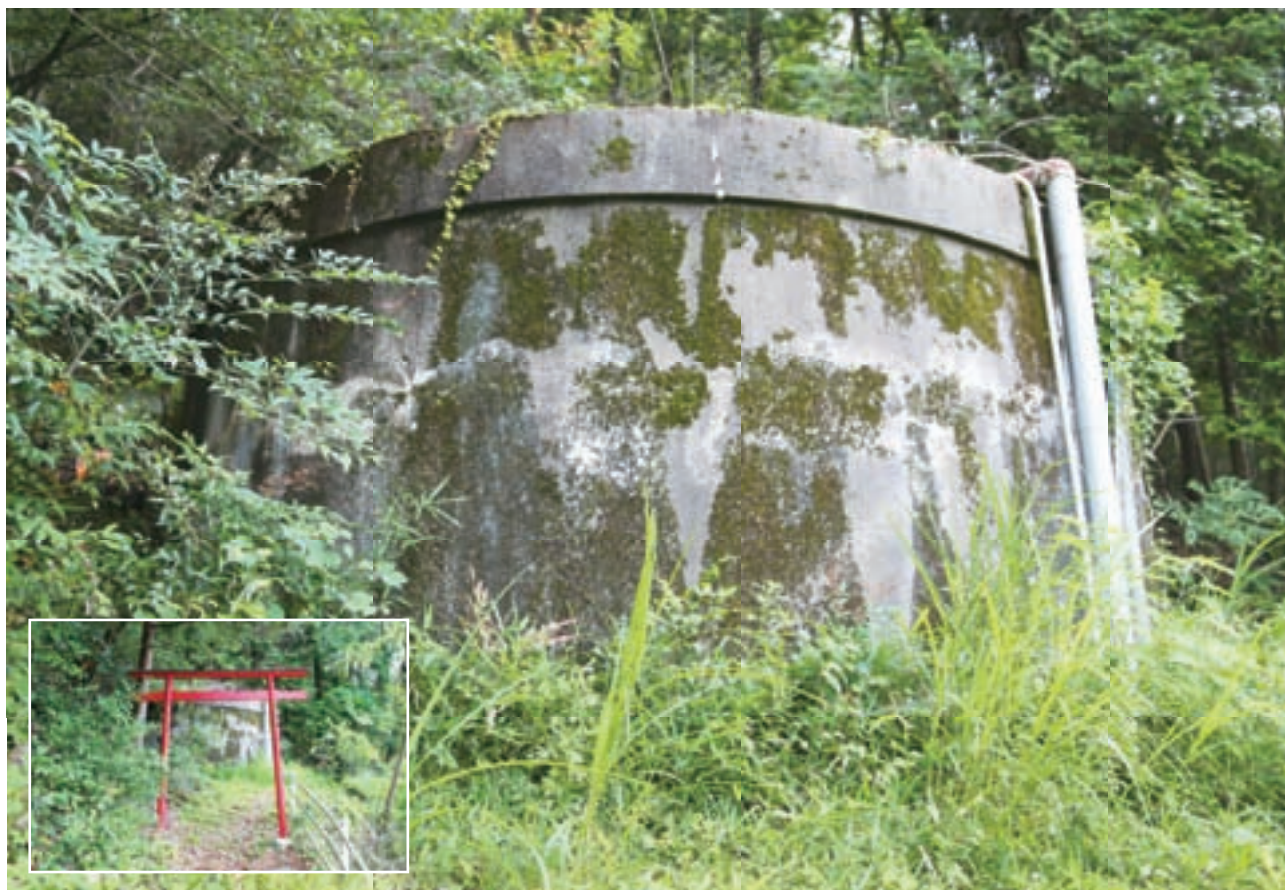
▲ 伊自良村簡易水道配水池 日本初のPC(プレストレストコンクリート)タンクと目印の鳥居
