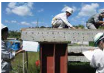
写真-3 現場試験の様子
