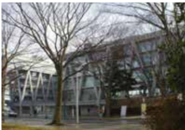
写真-1 人間・環境系新棟
