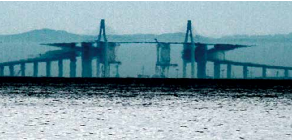
上：新湊大橋 / 下：富山湾に浮かぶ新湊大橋の蜃気楼
