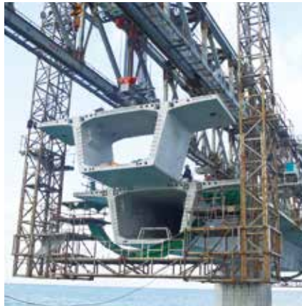
セグメント架設
