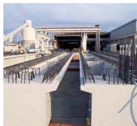
稲荷千歳高架橋のPCU桁
