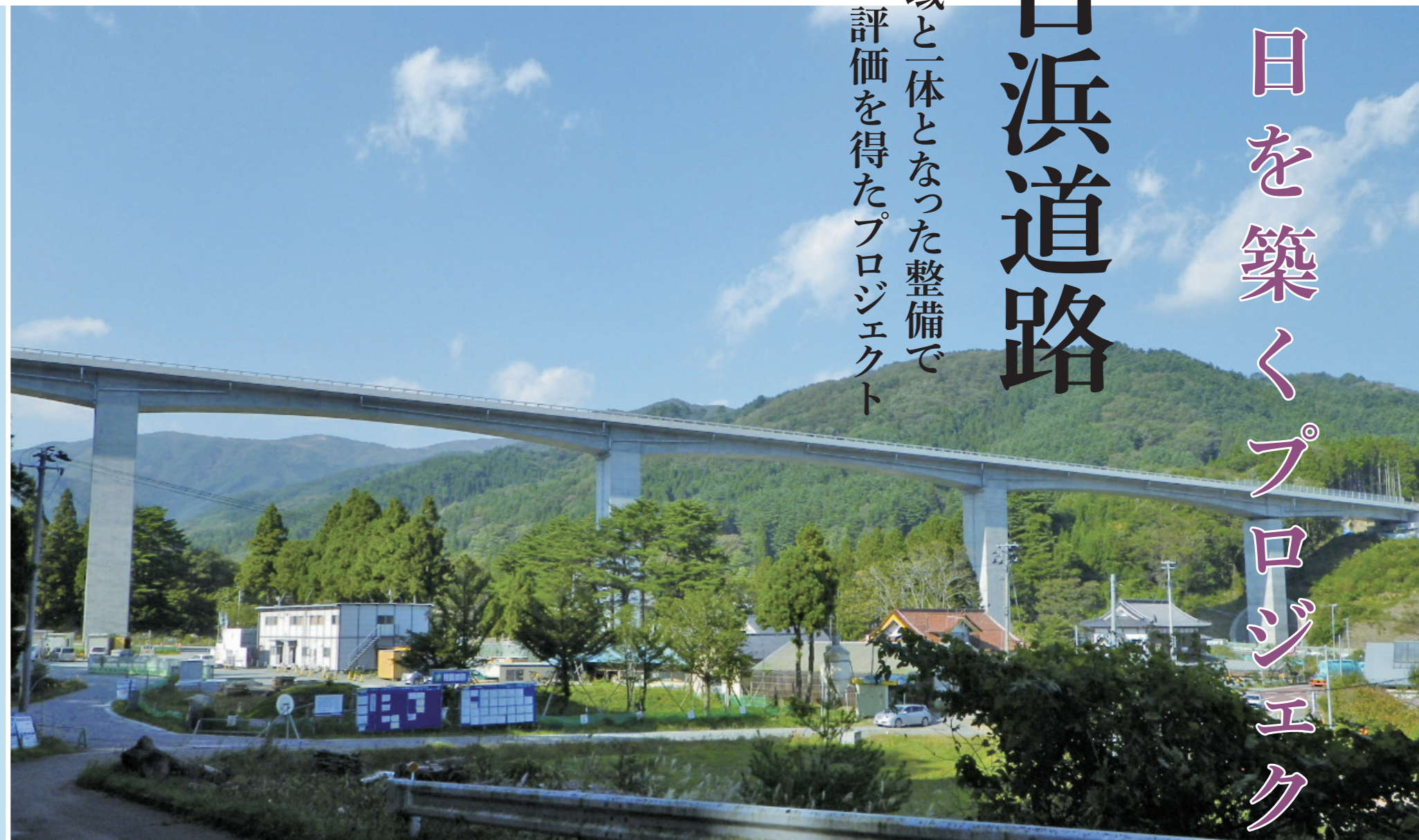
平成25年10月11日に連結式が行われた吉浜高架橋 (6径間連続PCラーメン箱桁橋)
