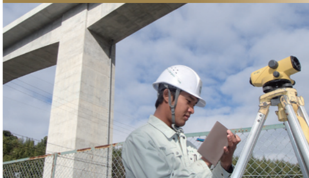
橋体完成後の出来形測量
