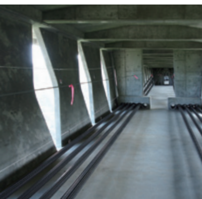
明るい桁内／ 光が差し込み、大変歩きやすいです
