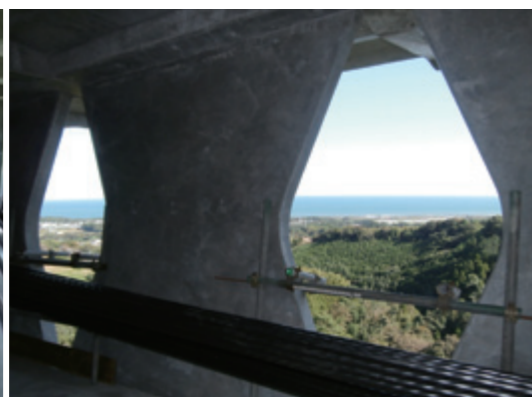
桁内から日向灘を望む／ 供用後は一般の方は見られませんが、眺めは格別です
