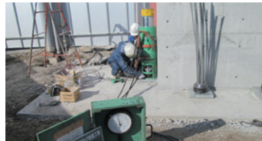
鉛直地盤アンカーPS導入状況
