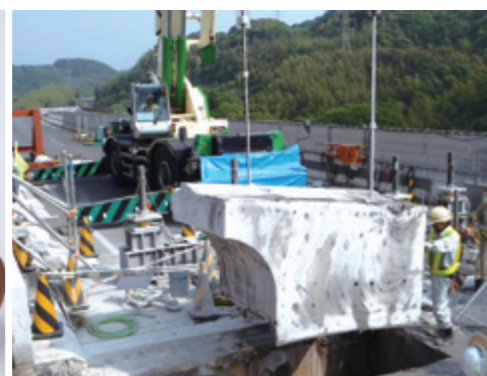
切断したブロックの撤去
