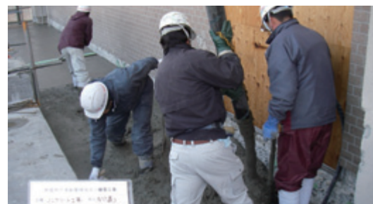
スラブコンクリート打設状況
