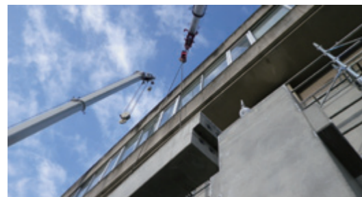
PC梁建て方状況
