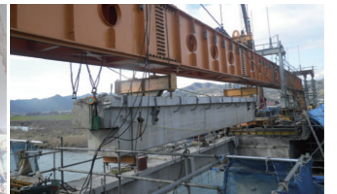
ゲルバー桁部の撤去
