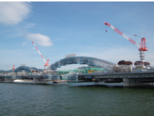
ヤジロベエ施工
