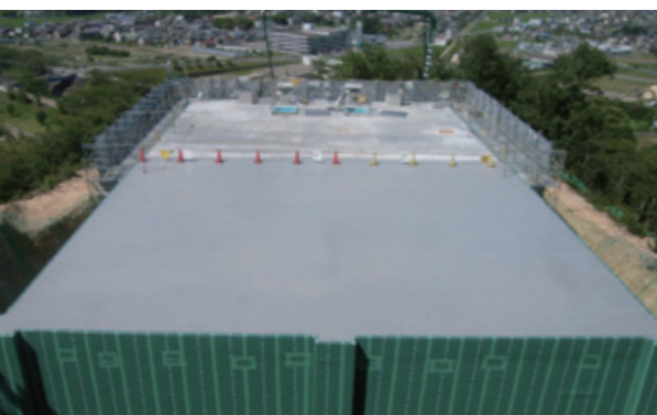
埋戻し前・防根シート貼付状況
