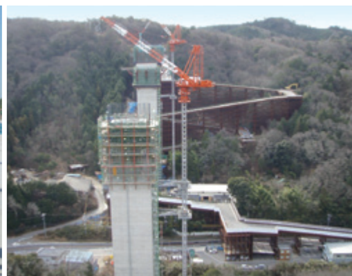
クライミングフォームによる橋脚施工と仮橋
