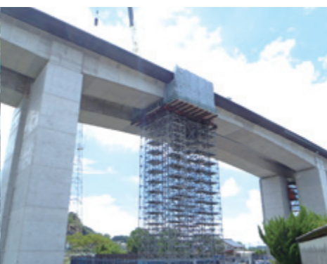
切断部を支える支柱
