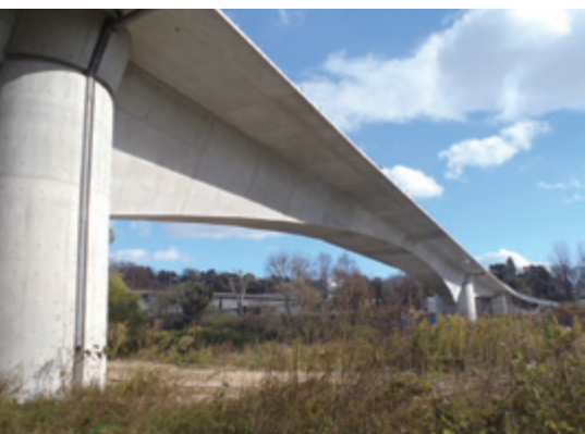
変化をもたせた橋桁の底
