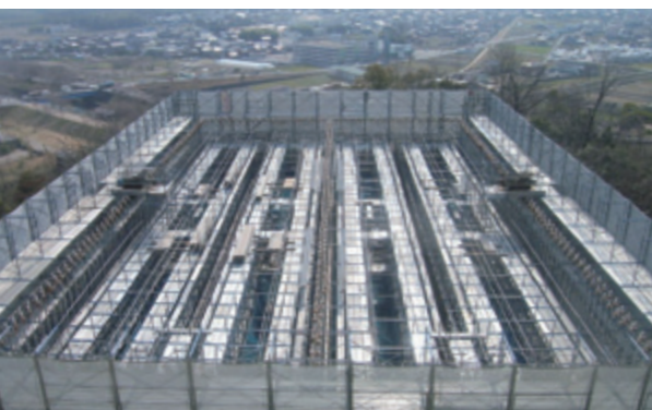
壁部施工状況
