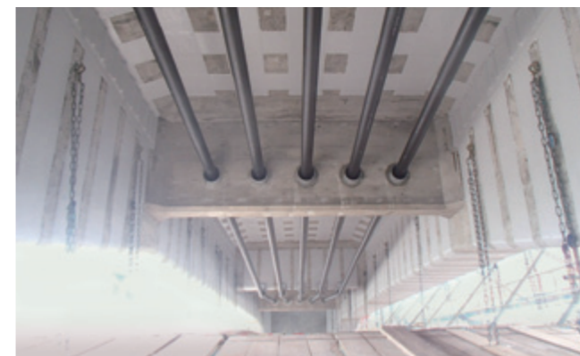
外ケーブルの設置
