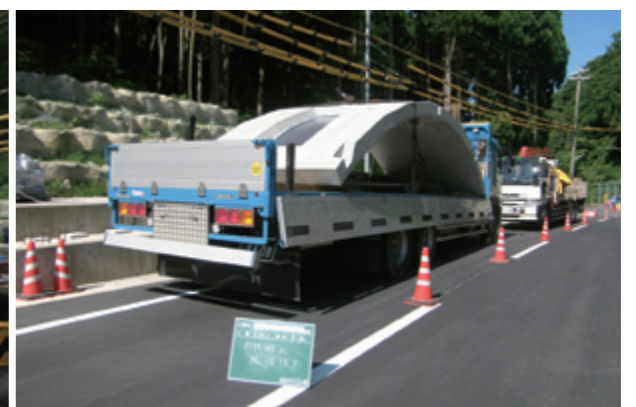
部材運搬状況
