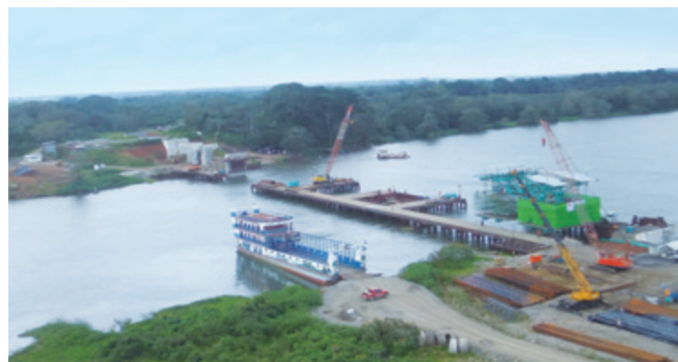
工事現場に隣接するフェリー乗り場
