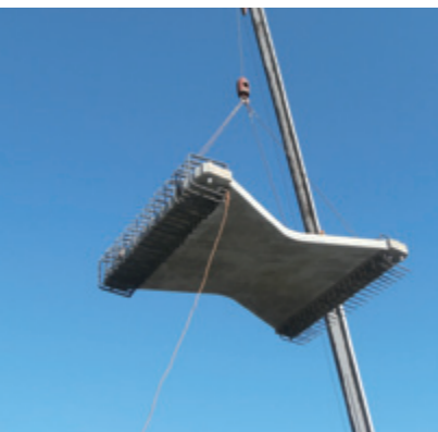
バタフライウェブパネルの架設／ 蝶が飛んでいるように見えます
