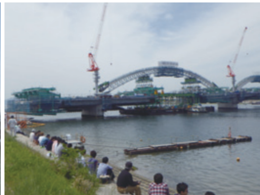
アーチ大ブロック架設
