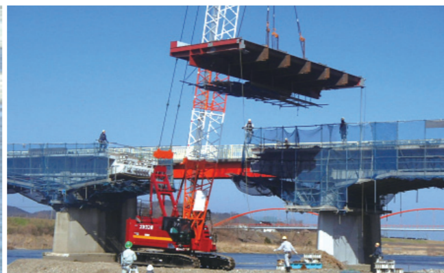
ゲルバー桁部の架設
