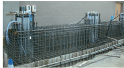
基礎梁配筋状況
