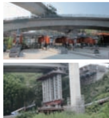
写真-2 特殊移動作業車を用いた3層構造部の施工、アンバランスな張出施工に仮支柱を採用
