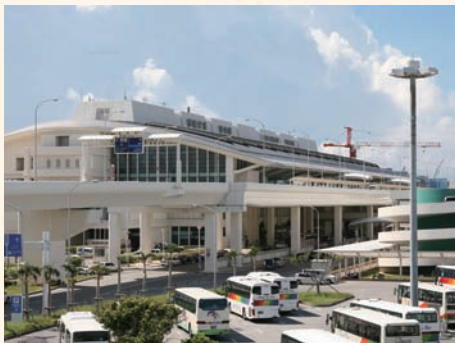
那覇空港 | 国内5位の利用客を誇る沖縄・空の玄関口。自衛隊と共用。国内線旅客ターミナルビルは塩害に強いPCaPC構造を採用。
