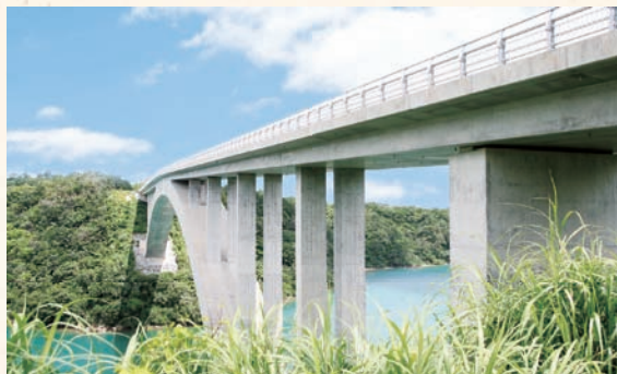
ワルミ大橋 | 屋我地島と本部本島を結ぶ海峡横断橋(全長315m)。鋼管内にコンクリートを充填する合成鋼管アーチ巻立て工法を採用し、耐風性に優れる。
