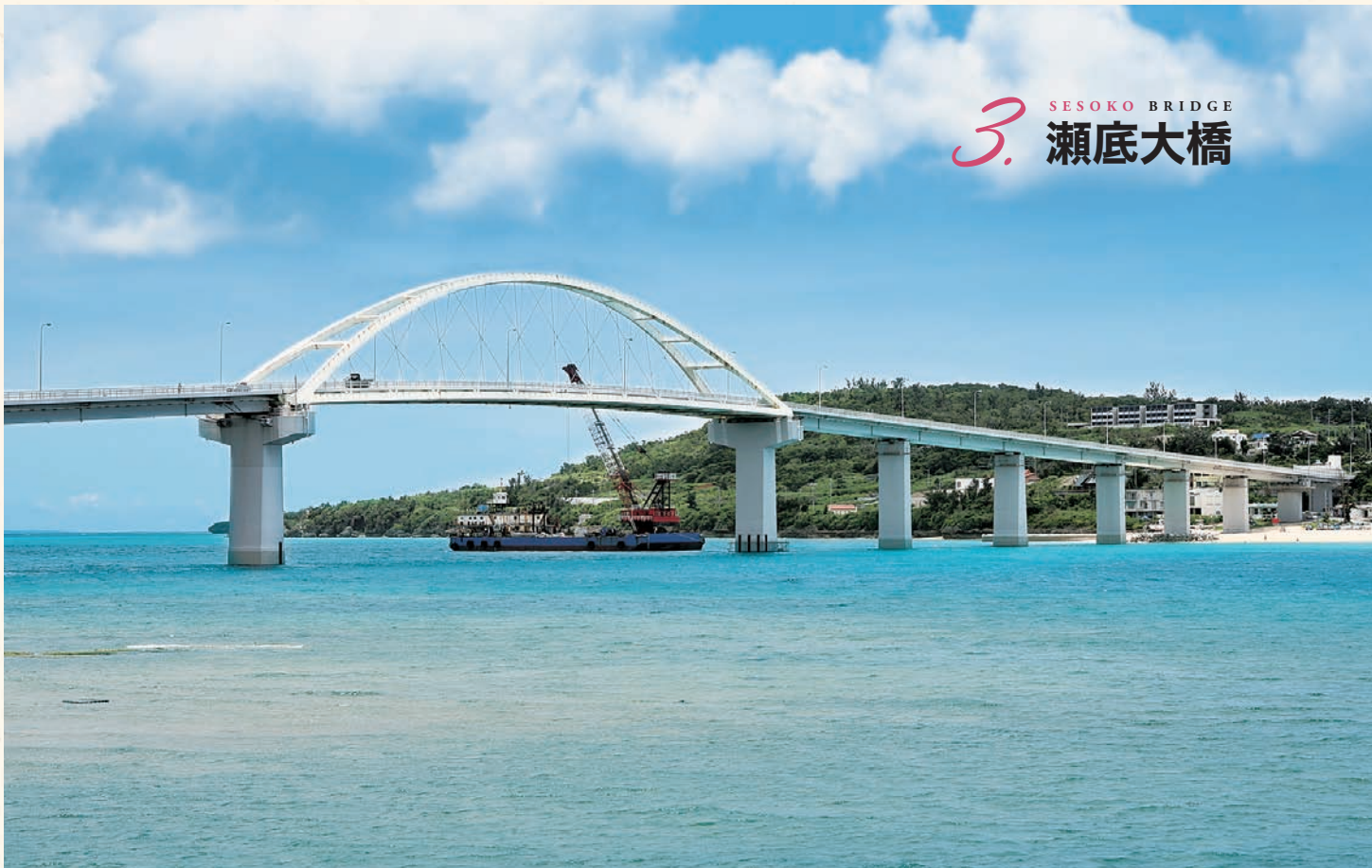
瀬底大橋 | 本部町と瀬底島を結ぶ橋長762mの橋梁、中央部はニールセンローゼ桁(鋼橋 141.5m)のアーチ橋、側径間はPC3径間連続箱桁橋4連とT桁橋2連で構成される。
