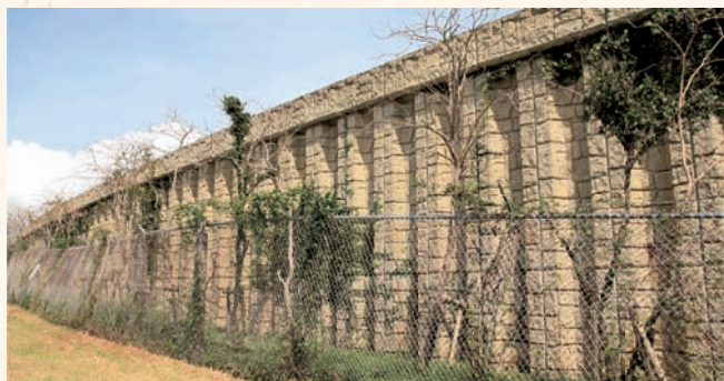
嘉手納飛行場側壁 | 在日米空軍基地を囲む壁は、外周の一部に石積みをイメージしたPC波形矢板を採用。基地の敷地面積は羽田空港より広く、約1,997haある。
