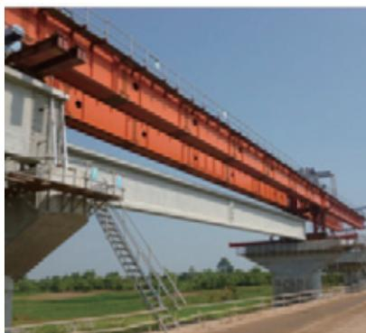
写真-1 アプローチ橋PCI桁架設
