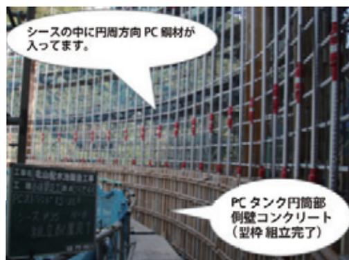
写真-1 円周方向PC鋼材配置
