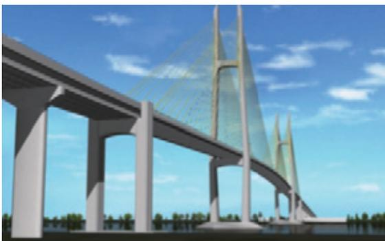
図-1 メイン橋バース（3径間連続PC斜張橋）
