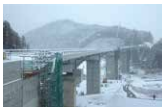
▲担当した橋梁現場の雪景色
