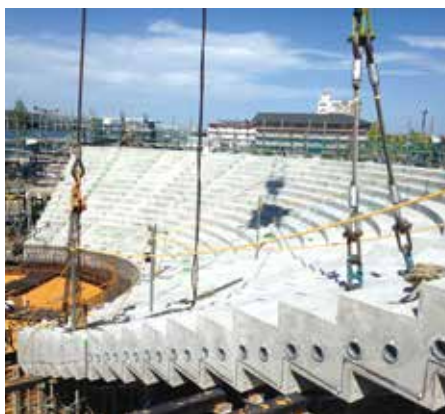
▲ 写真5 ふわふわコフン施工状況
