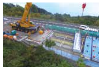
▲ プレキャストPC床版架設
