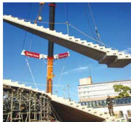
▲ 写真4 インフォ&ラウンジコフン施工状況
