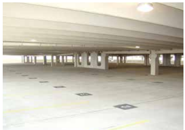
▲ プレキャスト部材を使用したアメリカ駐車場(内観)
