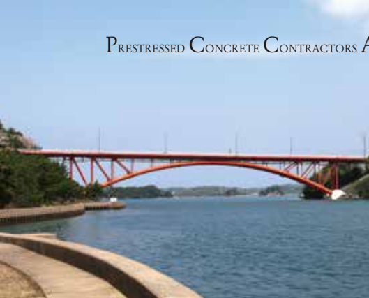
▲ 5号橋(松島橋):パイプアーチ・合成桁橋。全長177.7メートル。本格的パイプアーチとしては日本初(開通当時)。
