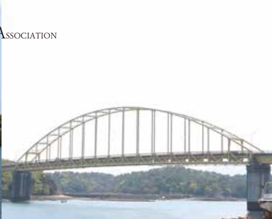
▲ 2号橋(大矢野橋):ランガートラス・合成桁橋。全長249.1メートル、ランガートラス156メートルは日本第1位(開通当時)。
