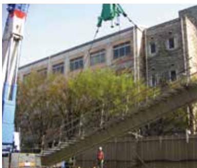
▲写真6 現場施工時（撮影：ピーエス三菱）
