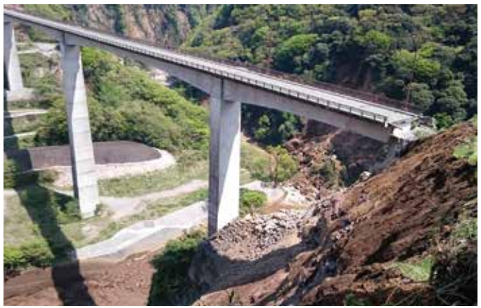
▲ 橋台が損傷した阿蘇長陽大橋
