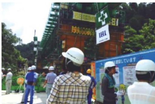
現場見学（上分二号橋：PCU コンポ橋）
