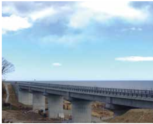
▲久之浜バイパス 古内橋
