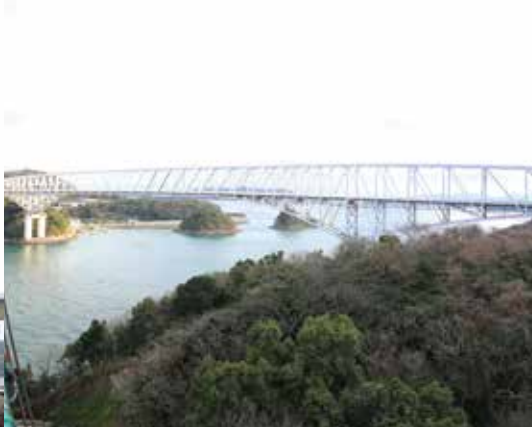
▲ 1号橋(天門橋):連続トラス橋は全長502メートル、中央径間300メートル。連続トラスとしては世界第1位(開通当時)。海面からの高さは42メートルで大型船も航行できるようになっている。
