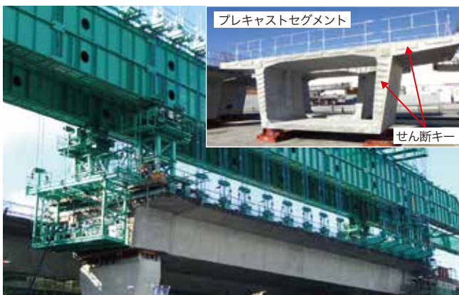
▲プレキャスト技術を活用した鈴鹿高架橋 (15個のプレキャストセグメントをプレストレスで一体化)
