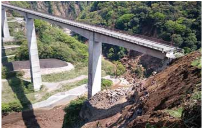
▲ 橋台が損傷した阿蘇長陽大橋
