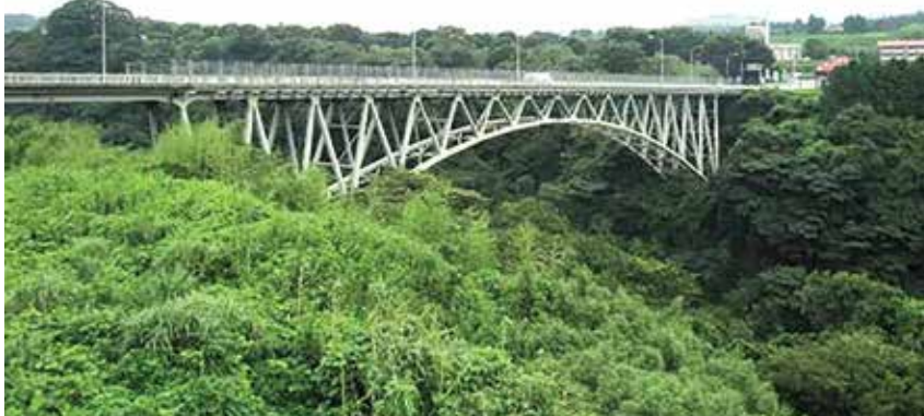
▲ 落橋した阿蘇大橋
