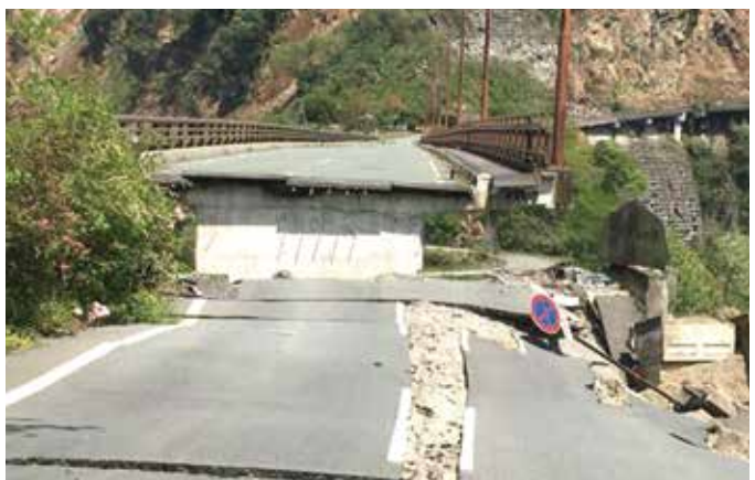
▲ 阿蘇長陽大橋の段差(橋台側から本体を望む)
