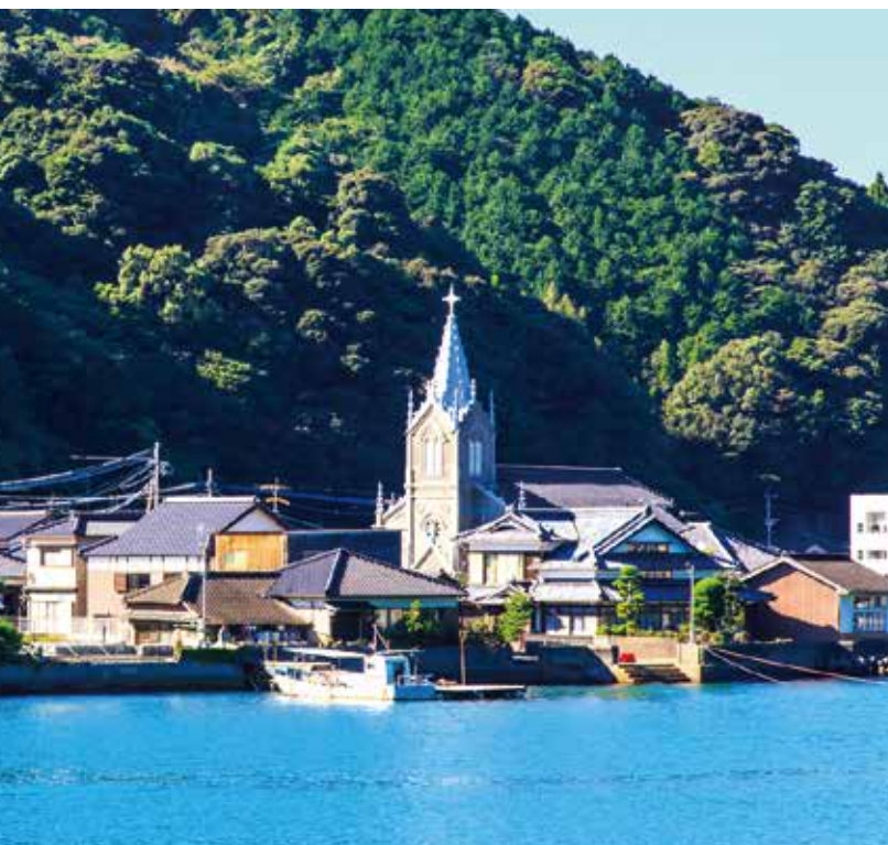
▲崎津教会 空へ向かって真っすぐに伸びる尖塔の上に十字架を掲げた重厚なゴシック様式の教会は、長崎の建築家・鉄川与助によって設計。現在の教会は1934年、フランス人宣教師ハルブ神父の時代に再建された。
