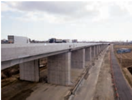
仙塩道路／多賀城高架橋
