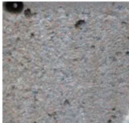
後打箇所洗出し面(赤い細骨材が廃瓦)
