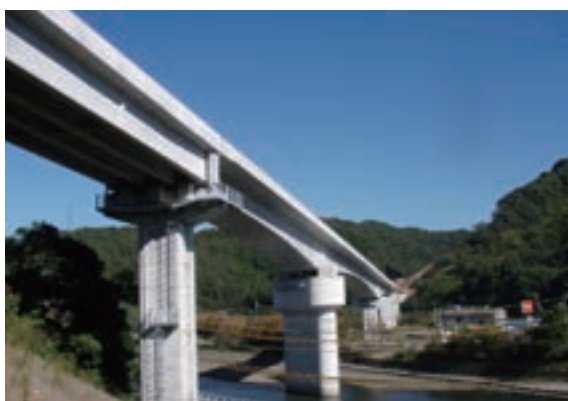
芦北出水道路／湯浦川橋
