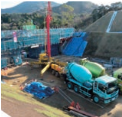
コンクリート打設状況全景
