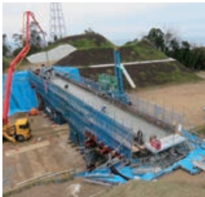
コンクリート打設完了直前の全景
