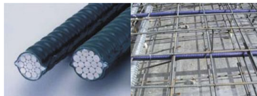
写真-2 プレグラウトPC鋼材
